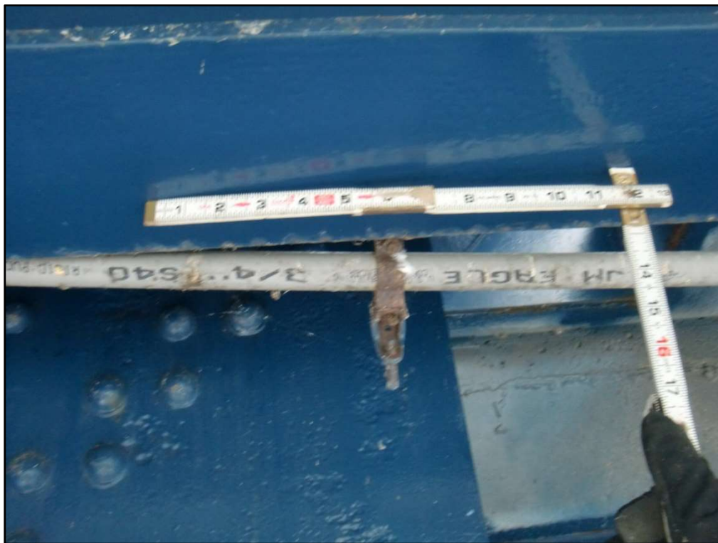
Photo 56 – Broken Electrical Conduit & Hanger
