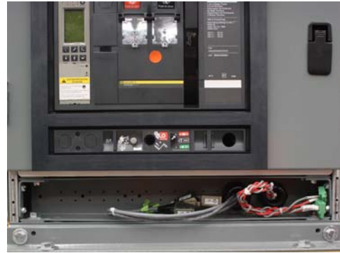
Figure 35 : Exemple de câbles de communication temporairement entreposés dans un caniveau pour leur expédition
