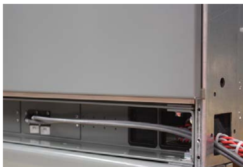
Figura 39: Cables ULP dirigidos y conectados a los puertos ULP etiquetados en el ducto para cables de la sección adyacente
