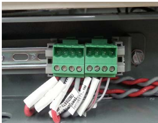
Figure 41 : Connecteur fixe Modbus RS485 du côté gauche du caniveau avant inférieur
