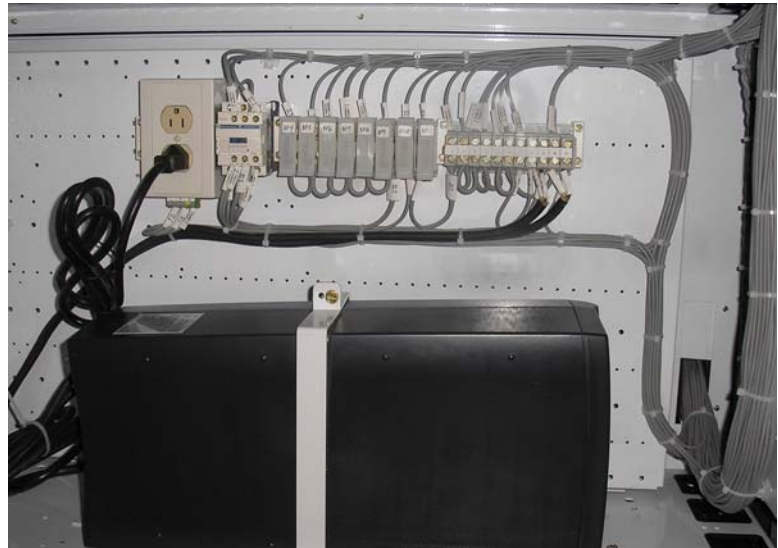
Figura 14: Ensamble del sistema de alimentación ininterrumpida (UPS)
