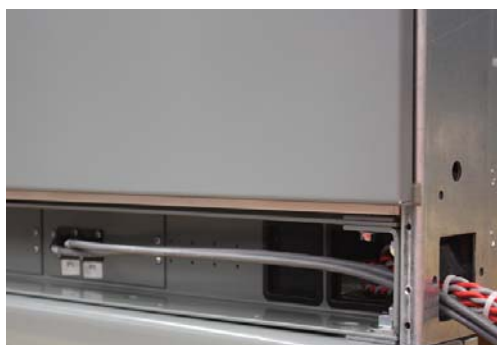
Figure 39 : Câbles ULP acheminés et raccordés aux ports étiquetés ULP du caniveau de la section adjacente
