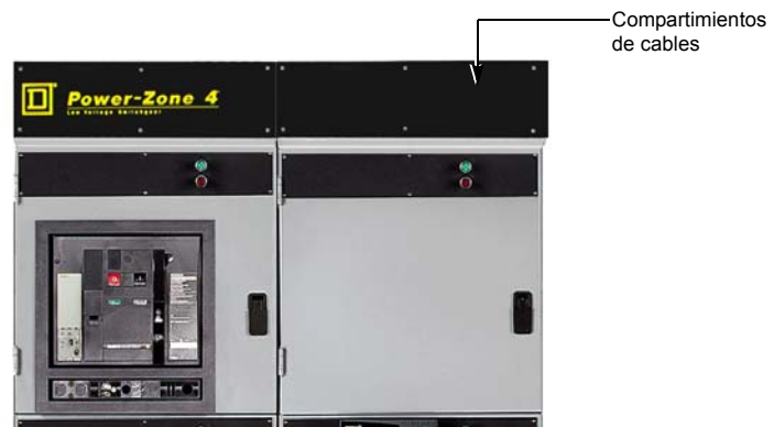
Figura 9: Desmontaje de las cubiertas de los compartimientos de cables
