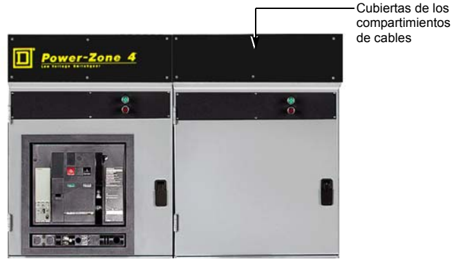
Figura 34: Desmontaje de las cubiertas de los compartimientos de cables
