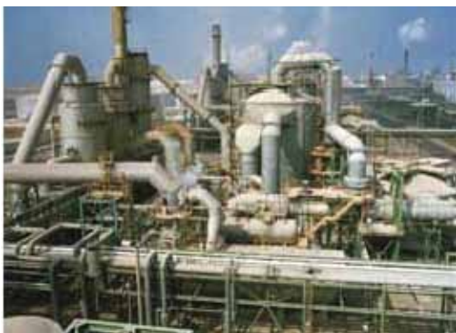
Figura 6 – Presencia de polvo
