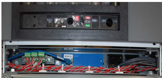
Figure 42 : Exemple de raccordement de câble Ethernet Modbus TCP (bleu) au port étiqueté Ethernet
