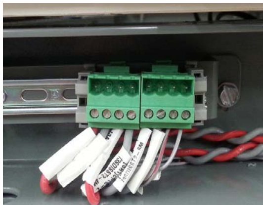
Figura 41: Conector fijo Modbus RS485 en el lado izquierdo del ducto para cables frontal inferior
