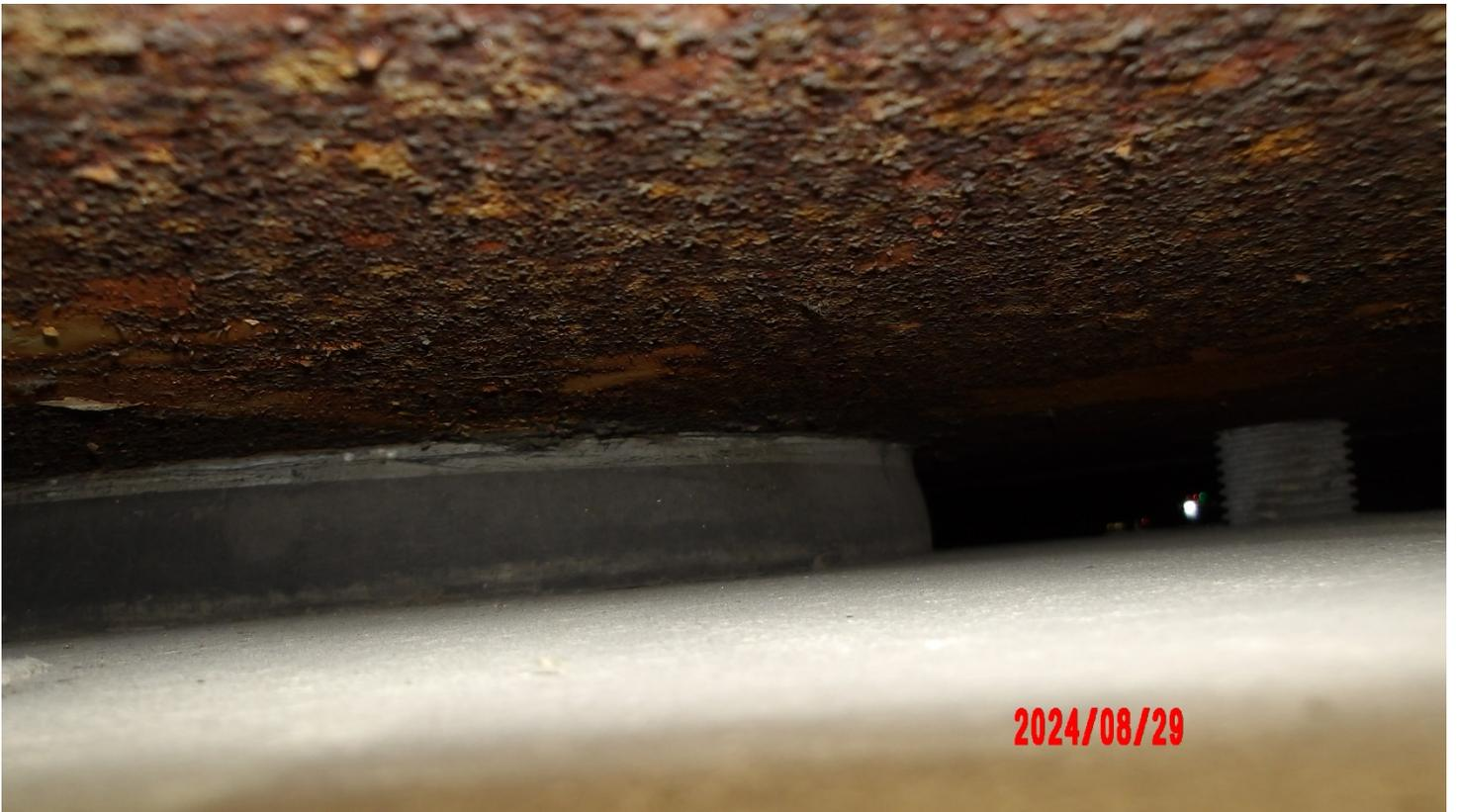
PHOTO 19. ELASTOMERIC BEARING PIER 25J
