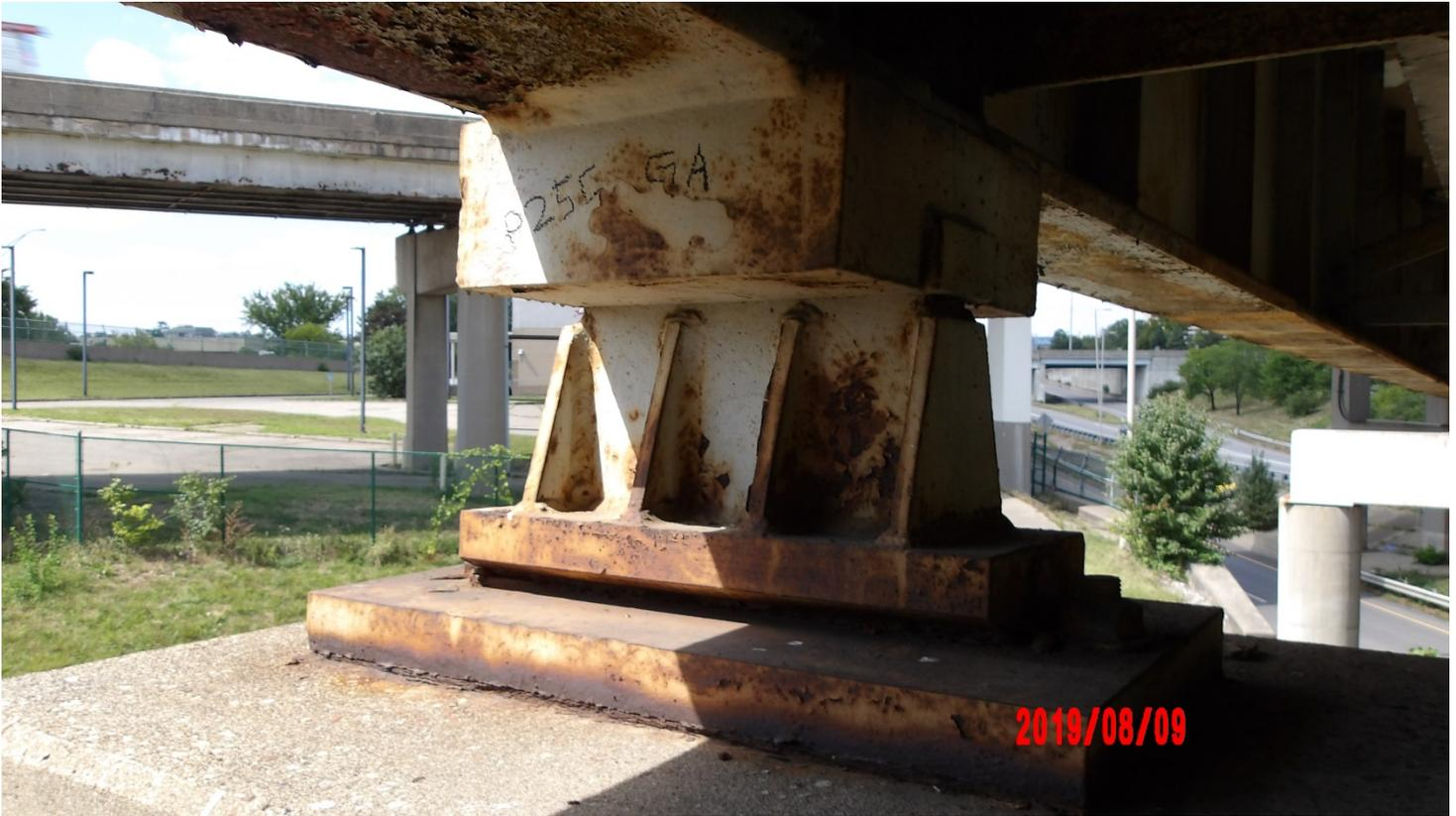
PHOTO 23. MOVABLE BEARING A PIER 25C
