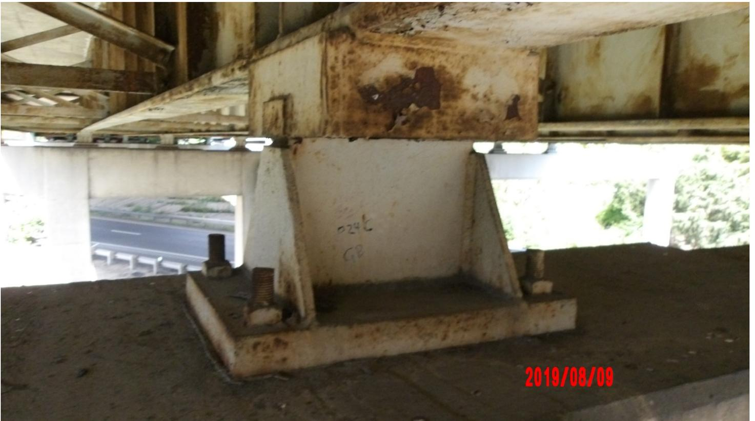
PHOTO 25. FIXED BEARING B PIER 24C
