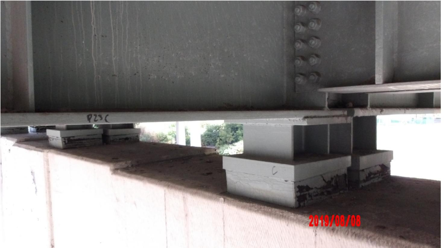
PHOTO 18. ELASTOMERIC BEARING C PIER 23C
