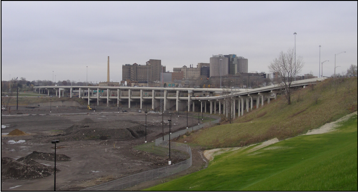
Photo 1– Elevation View of CUY-71-1791R & CUY-176-1334
