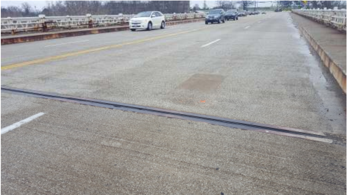
Pavement Photo C-7
